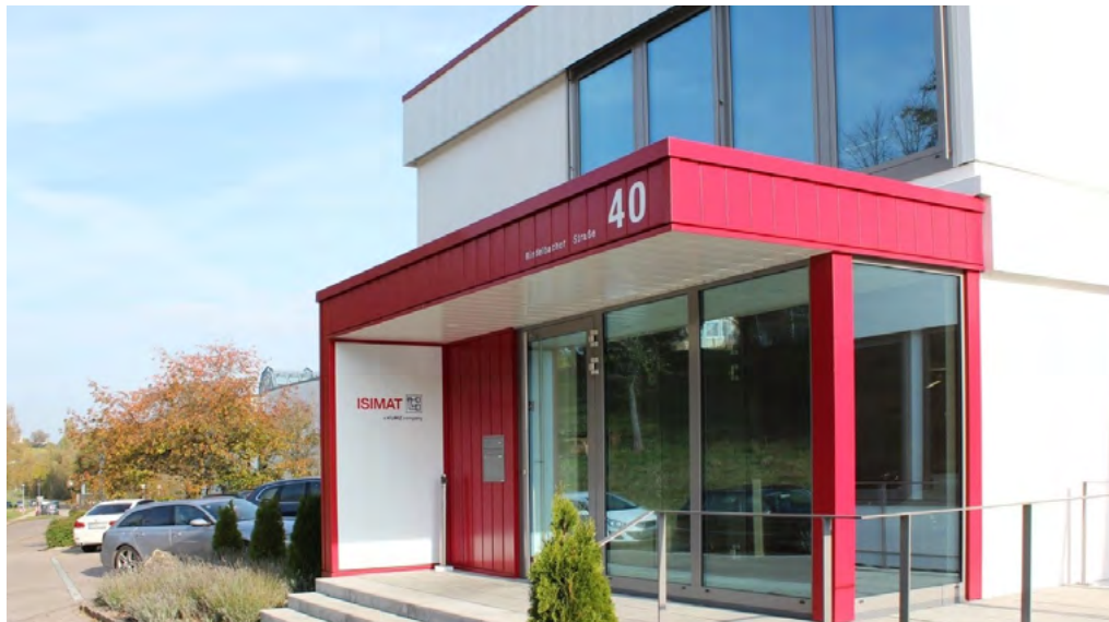
Abbildung 22: ISIMAT Firmengelände; Quelle: KURZ
