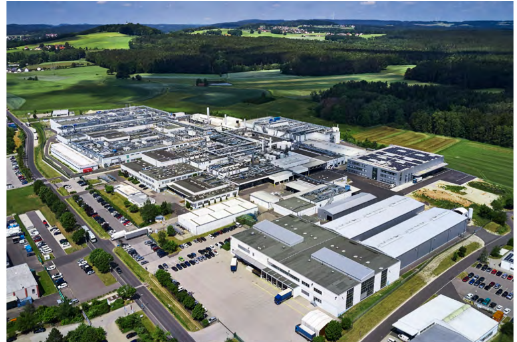
Abbildung 12: Unternehmensgelände Sulzbach-Rosenberg; Quelle: KURZ
